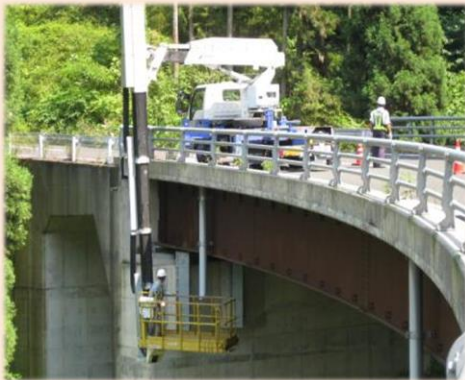
橋梁点検車による点検
